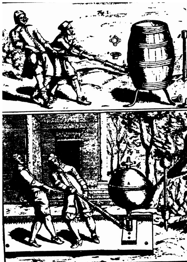
Guericke sikertelen (fent) és sikeres (lent) kísérlete a vákuum előállítására
