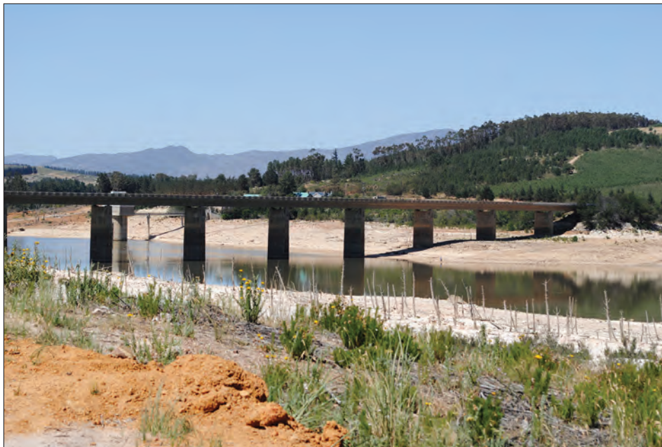
2. kép A Theewaterskloof-tározó (Western Cape tartomány, Dél Afrika), a helyi vízgazdálkodási rendszer talán legfontosabb eleme 2017 novemberében. Az üzemeltetés az alacsony vízállás miatt már a száraz időszak közepére veszélybe került. A vízhiány mértéke ellenőrizhető a hídpillérek sötétre színeződött – normális körülmények között vízbe merülő – alsó felén (A szerző felvétele)
