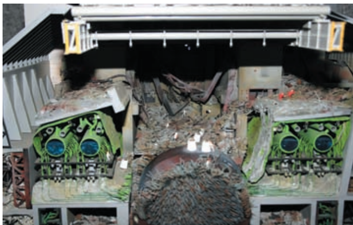
7.19. fotó. A törmelékhalom és a szarkofág teteje a maketten (A piros színű figurák azt jelképezik, hogy az elhárítási munkák során az adott helyen jártak bent emberek)
