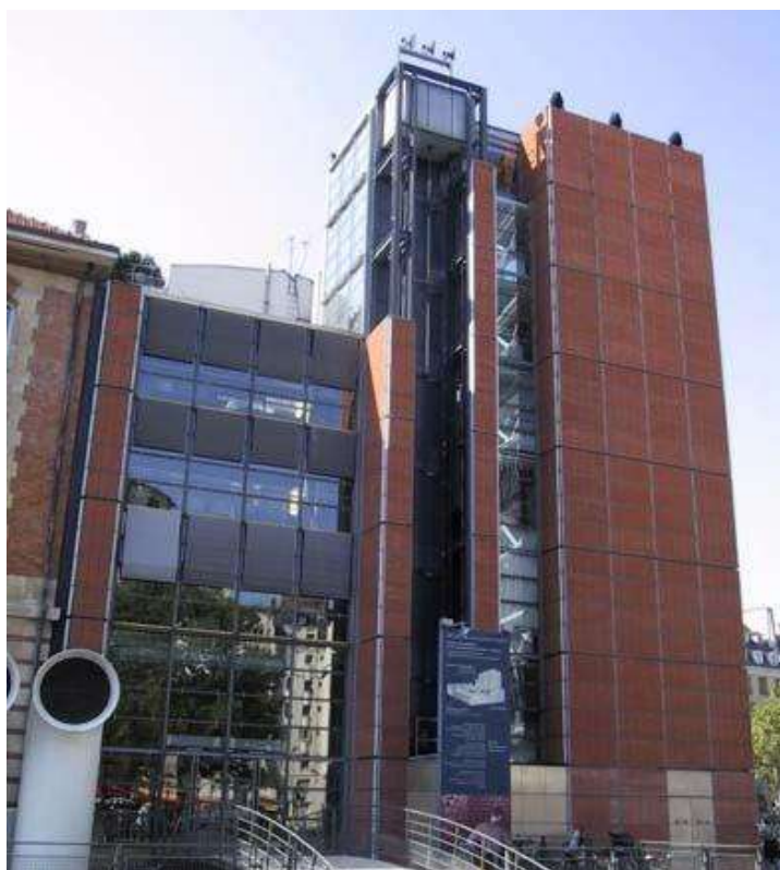
12.7. ábra: Az IRCAM épülete a felszín felett
